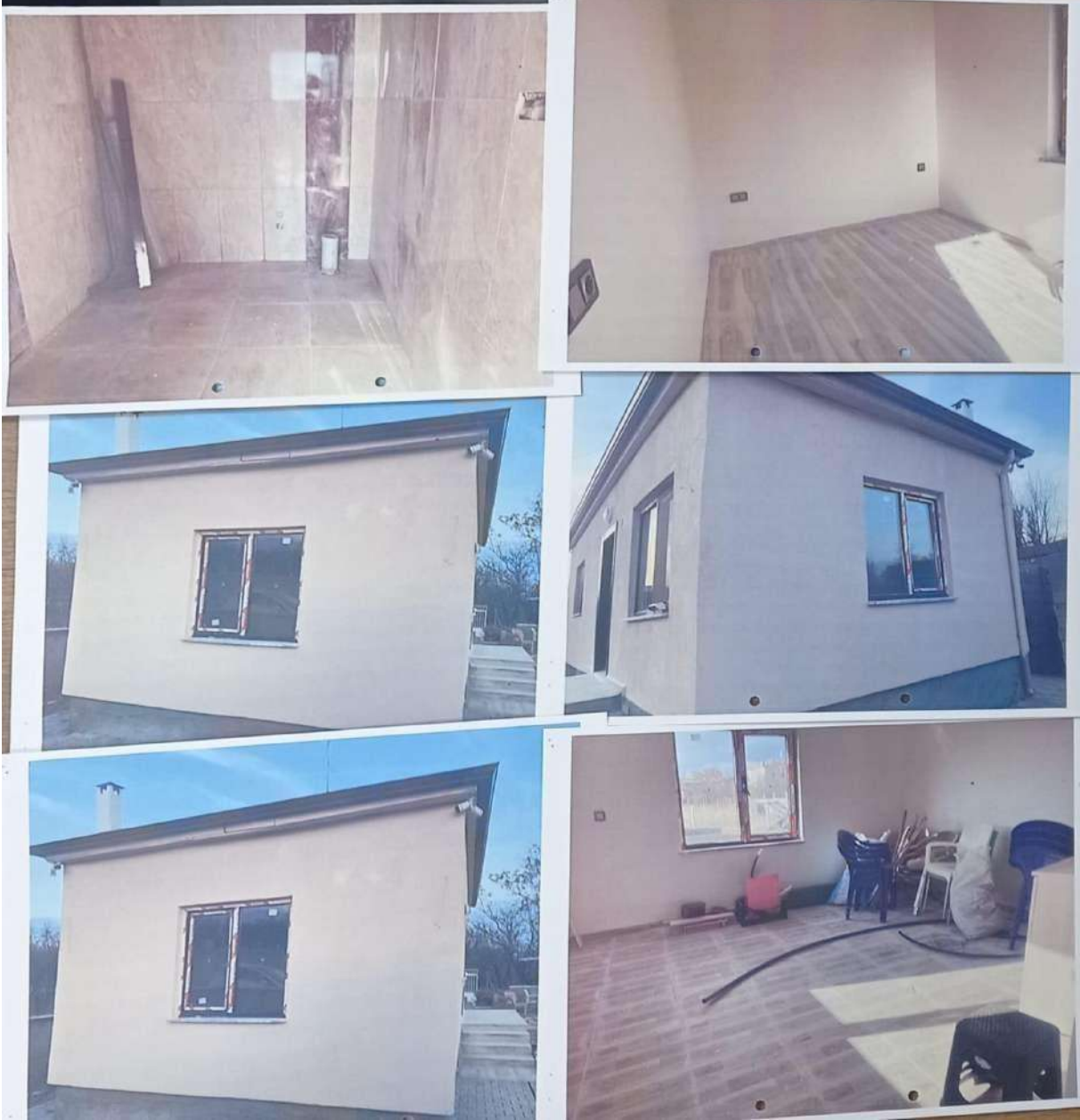
Yapı Denetim Mevzuatına Tabi Olmayan İnşaat Kontrol Çalışmaları
